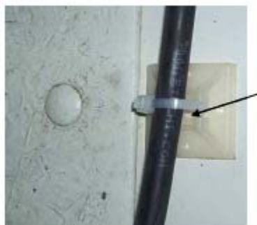
Рисунок 9 Крепление кабеля
